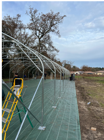
Montage de serre avec les CAPa de la MFR de Aire /Adour
